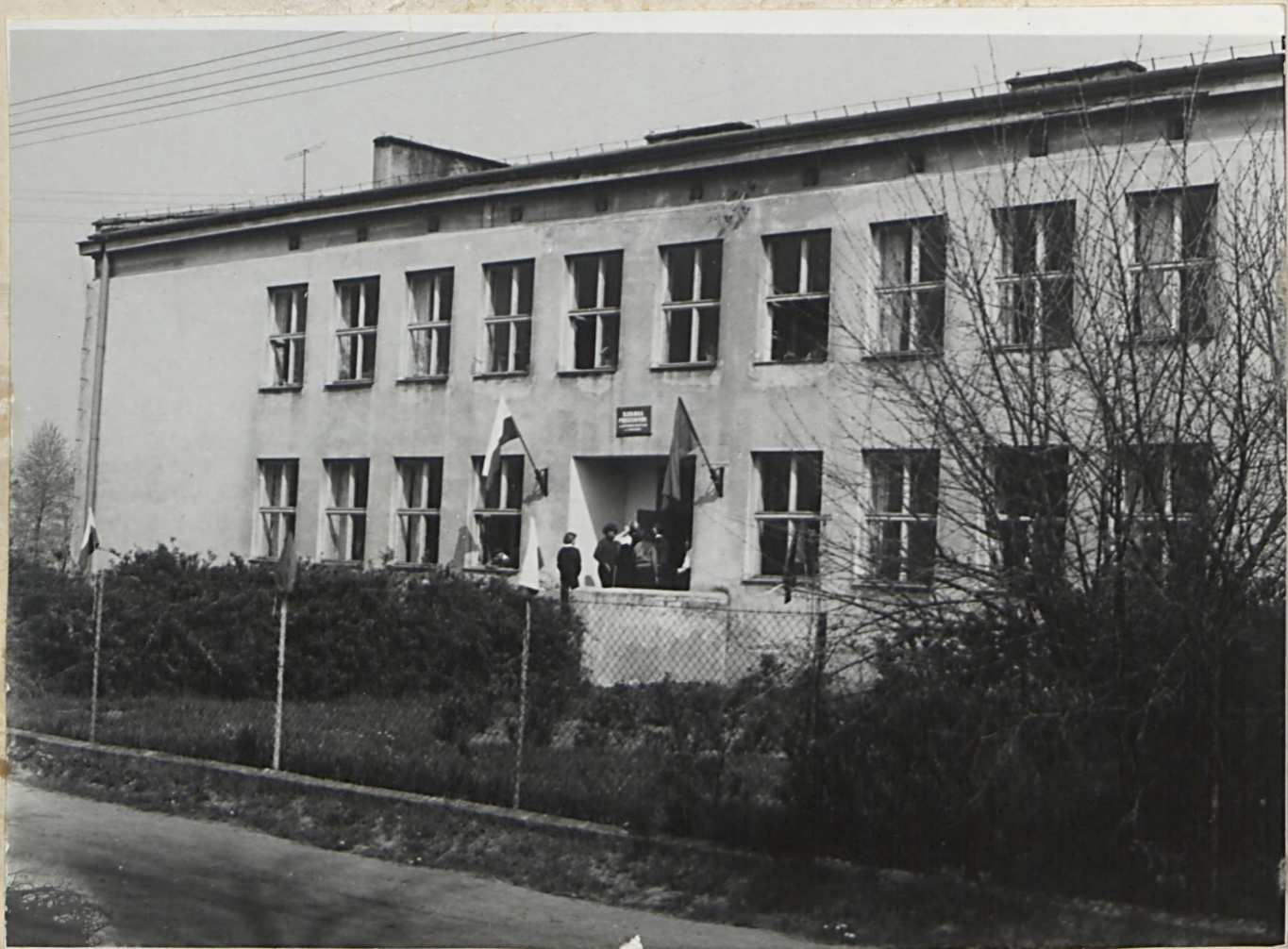
Nowa szkoła po wykonaniu prac inwestycyjnych i osiedlenia.
